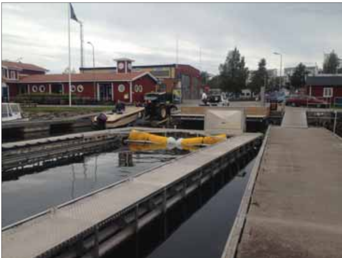
Bild: Bootwaschanlage in Nynäshamn.
